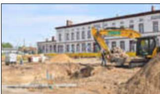
Die Straßen- und Kanalbauarbeiten für den ZOB und den Bahnhofsvorplatz haben im Juni begonnen. Derzeit wird die Regenwasserkanalisation verlegt. Entsprechend des aktuellen Bauablaufplanes soll in diesem Jahr ein Großteil des südlichen Baufeldes (Bahnhofstraße) fertig-
