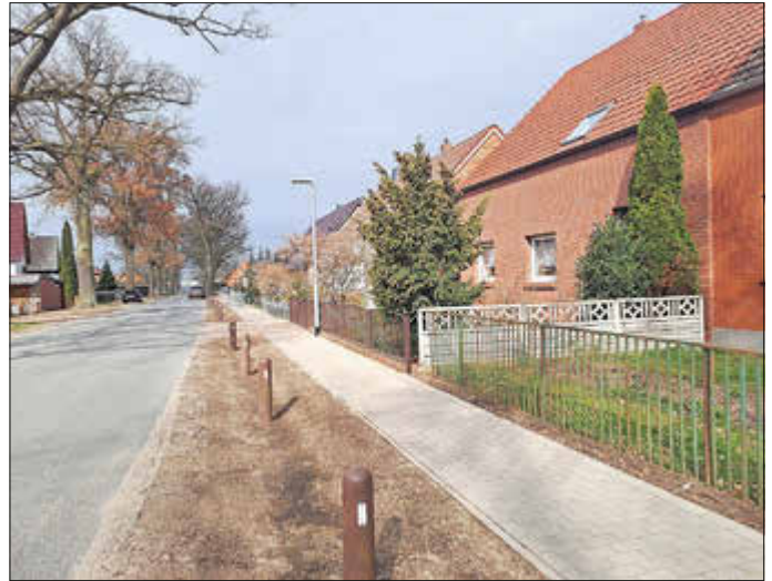
Poller sorgen dafür, dass die Entwässerungsmulden durch parkende Fahrzeuge nicht mehr verdichtet werden können. Fotos: Stadt Ludwigslust
