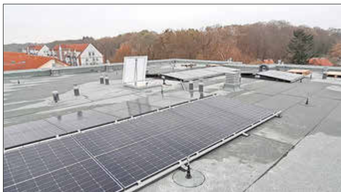
Blick aufs Dach
