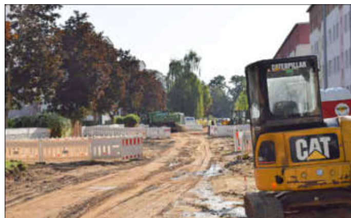
Baufahrzeuge bestimmen das Bild in der Tarnow-Straße
