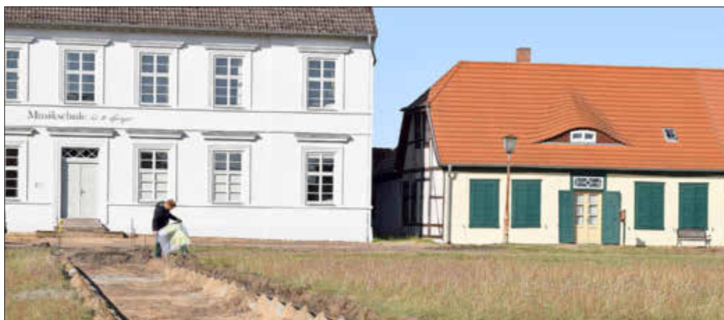
Wegebau auf dem Kirchenplatz
