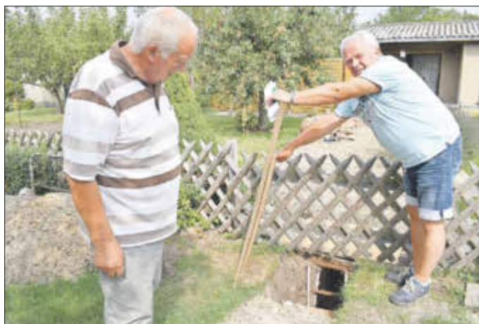
Wasserleitung in der KGA: Manfred Dunker (links) und Erich Münn an den Anschlußstellen zu den Gärten Fotos: SW
