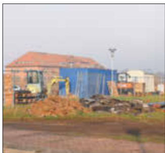
Hier entsteht das neue Wohngebiet Helene-von-Bülow-Straße
