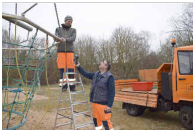
Stefan Westphal und Volkmar Mühle wechseln verschlissene Ketten am Spielkorb aus.
