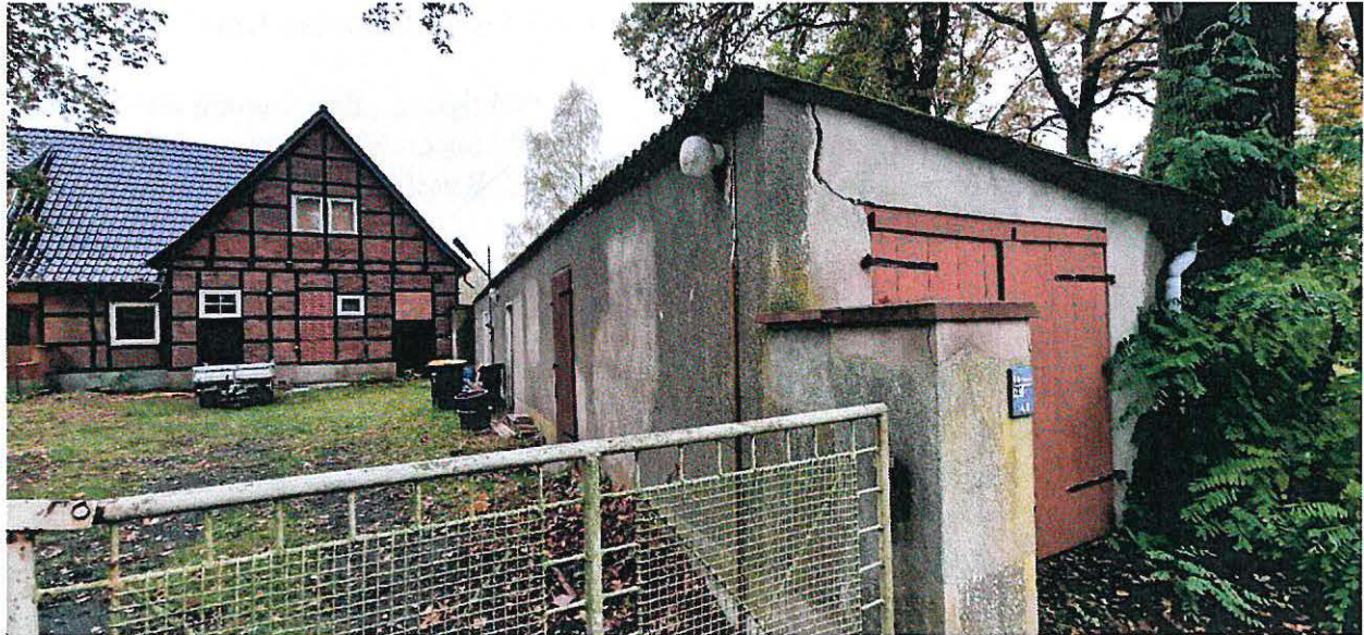
Abbildung 4 Blick von Osten in Richtung Westen auf einen Teil des ehemaligen Sportlerheims und eines der vorhandenen Nebengebäude, Foto St. Schulz, 28.10.2023
